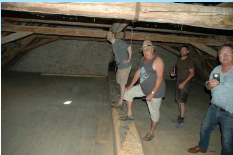
Les hommes de l'art vérifient la bonne répartition des points de traitement de la charpente de la nef
